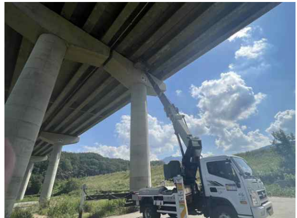
고소점검차를 이용한 근접조사
